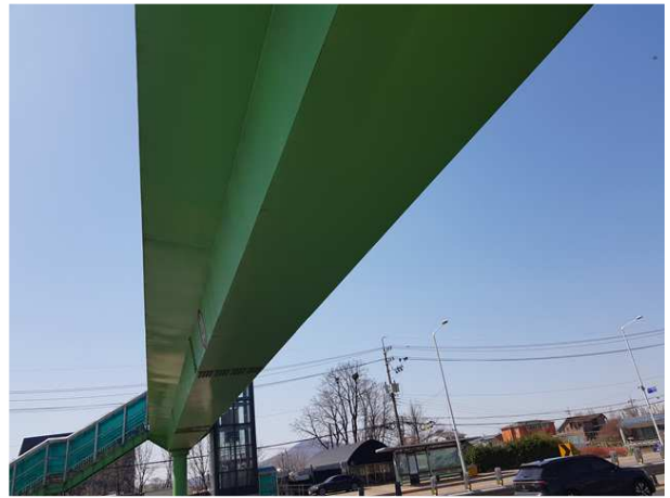
바닥판하면 및 거더 전경
